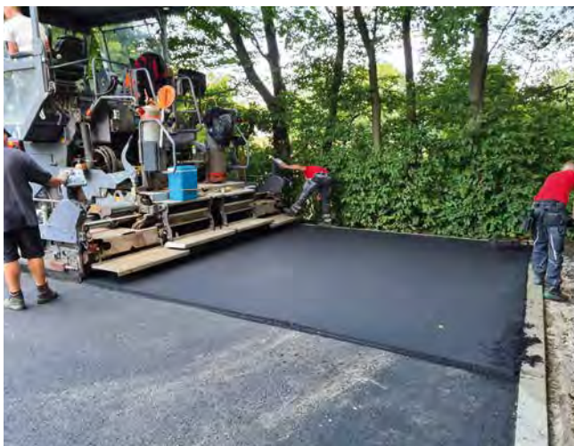
Bild 5: Einbau des Baskiphalt
